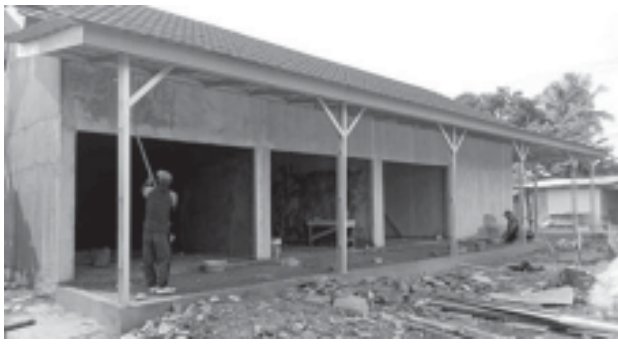
Kios Pasar Kampung Tri Dharma Wira Jaya yang dibangun dari Dana Desa.
