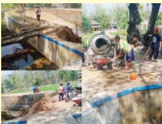
Kegiatan Rehabilitasi Embung Brumbung Parang. (ashar)
