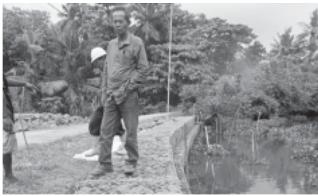
Pekerja sedang memasang bronjong di Dusun Pondok Wungu, Desa Kaliwungu, Kecamatan Kedungreja, Kabupaten Cilacap.
