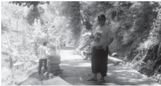
Tampak Pekerjaan P3 TGAI Mekarwangi 2
