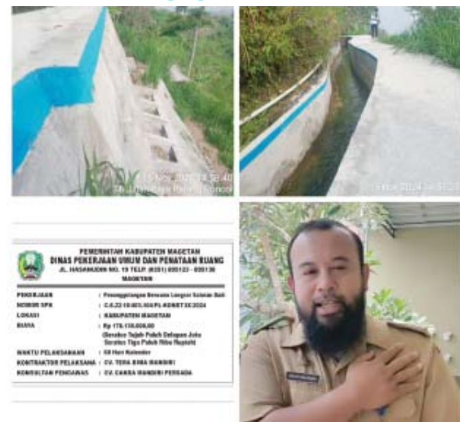
Proyek Penanggulangan Bencana Longsor Saluran Dadi Plaosan tampak sudah selesai dikerjakan.
