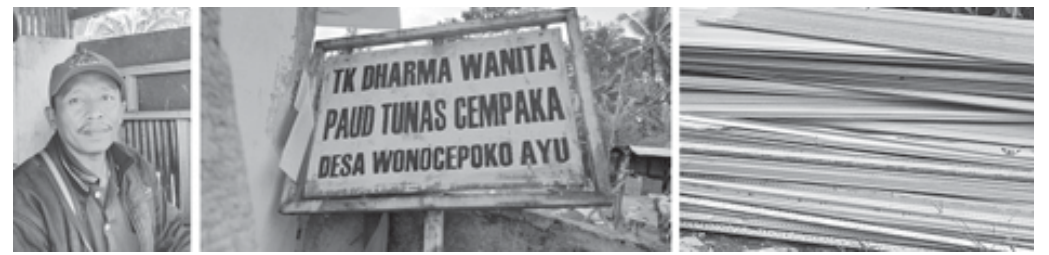
Sekdes Supa'at dan Bongkaran atap TK dan PAUD yang lama dipasang kembali di bangunan yang baru.
