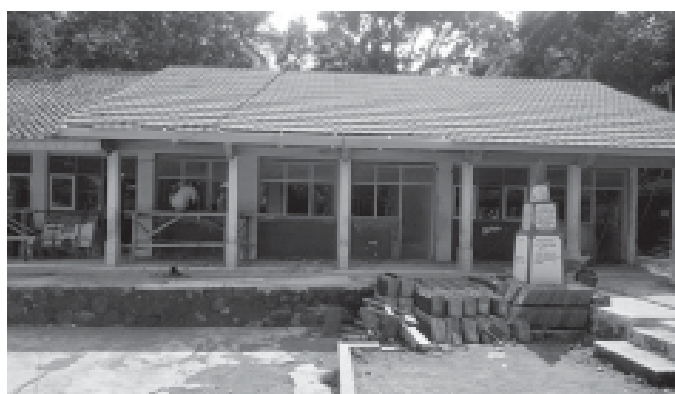
Ruang kelas SDN Sanepa, Kecamatan Buahdua yang direhab,
