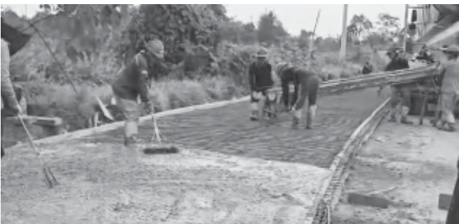
Pembangunan jalan cor beton oleh PT OKI Pulp
