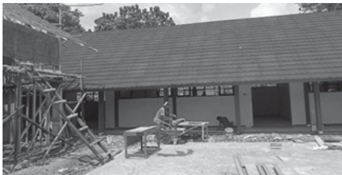
Proyek SMPN 4 Banjarsari dengan anggaran Dana Alokasi Khusus (DAK). (asep sujana)
