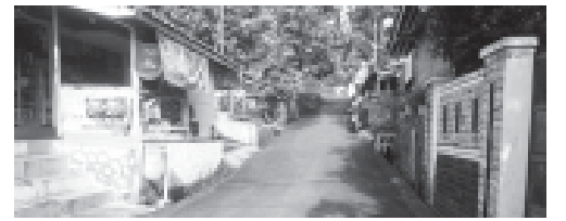
Jalan Dusun Setia Bakti nampak sudah di hotmix.
