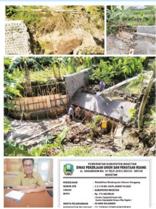
Bendungan Genggong di desa Randugede Kecamatan Paosan Kabupaten Magetan sedang direhab. (ashar)
