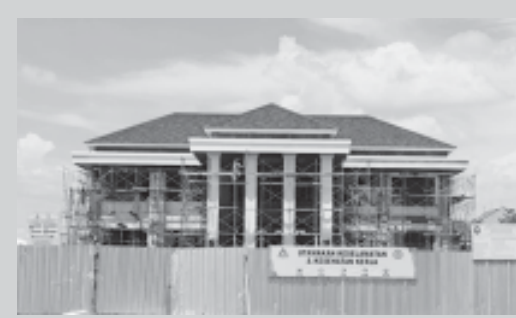
Bangunan Gedung Baru PN Sidoarjo masih dalam tahap pengerjaan. (teddy syah)
