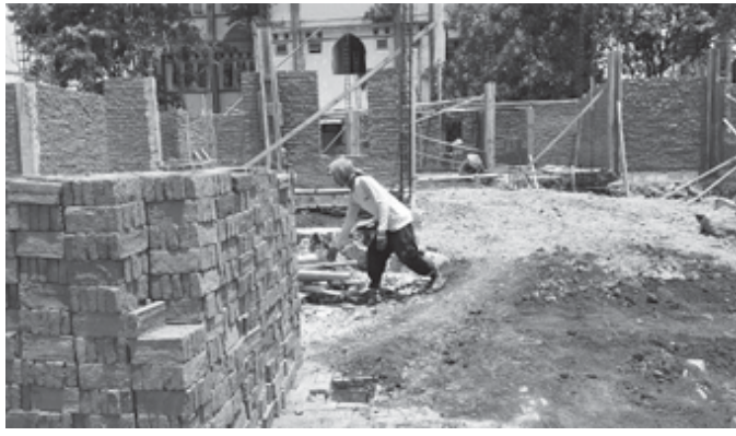
Proyek Gedung Kelurahan Panjang Baru, Kota Pekalongan. (Dikin)
