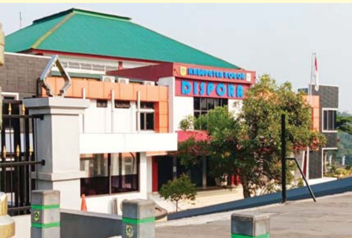
Gedung Kantor Dispora Kab Bogor, Komplek GOR Pakansari Cibinong Kab Bogor
