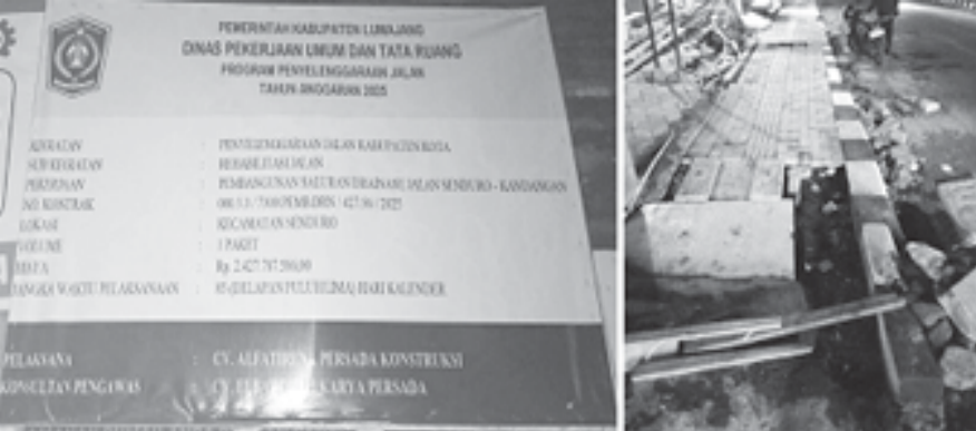
Papan proyek dan pekerjaan drainase jalan Senduro-Kandangan tampak amburadul
