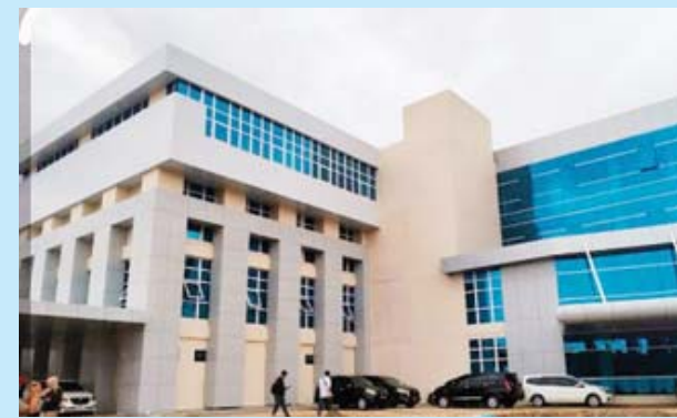
Bangunan gedung tahap ke 3 pembangunan RSUD Kraton di Wiradesa. (Dikin)
