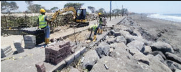
Bangunan pengaman pantai aset Balai Wilayah Sungai Bali Penida yang dibongkar di pesisir Pantai Padang Galak, Kesiman, Denpasar Timur. (awi)
