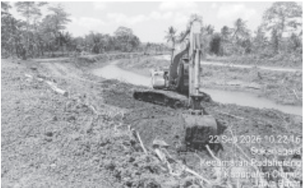
Pekerjaan Normalisasi Sungai Ciseel. (asep)
