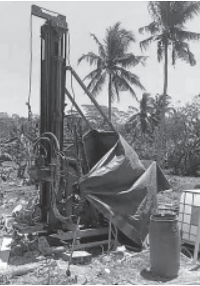
Aktivitas mesin bor proyek JIAT milik BBWS Citanduy di Desa Mangunjaya, Pangandaran. Pengeboran sedalam 135 meter di lokasi ini rencananya akan dipindahkan ke titik baru. (dok. foto: Asep Sujana)
